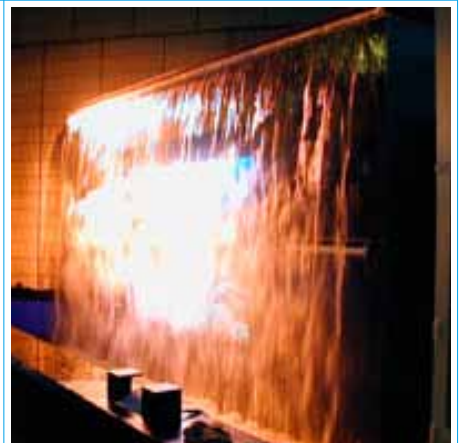
■特殊ノズルを使用して、透明な膜のように滝を出し、センサーによる霧噴出と、音楽・照明でプログラム。
