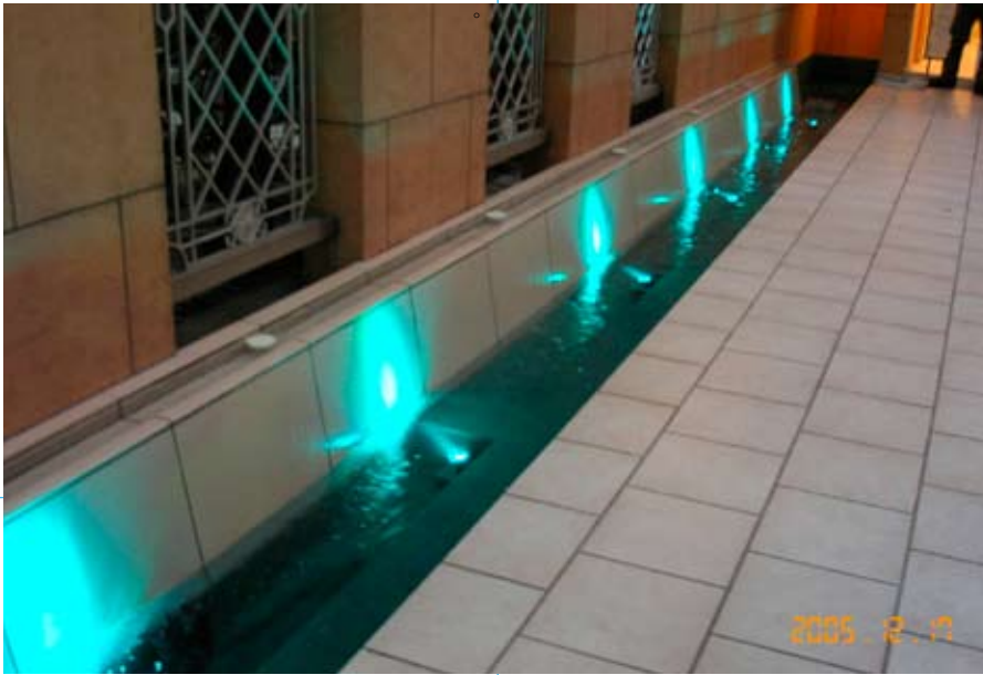
マンションエントランス LED 東京都 ■既存の噴水に LED 水中照明で演出。
