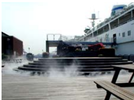
船の科学館 フォグシステム 東京都 ■イベント性を考慮した移動式のポンプユニットを利用して霧を演出。
