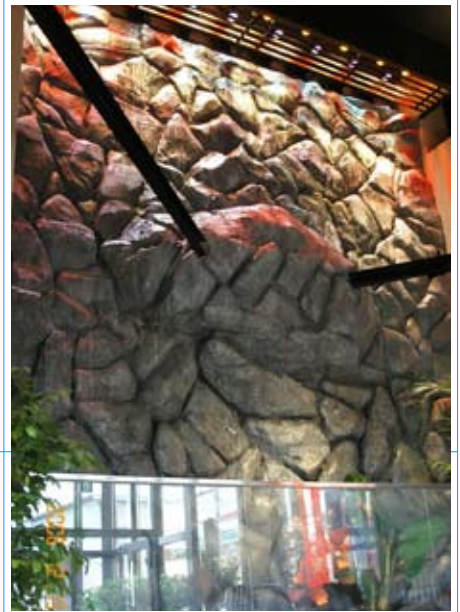
カフェレストラン 滝 山梨県 ■エントランスに、擬岩で高さ6mの壁面を造り上部から水を流し滝を制作する過装置は屋外に設置し循環させている。各所にバリ風の流れも造り、コンセプトにあわせて、フロア全体を南国イメージで水景演出。
