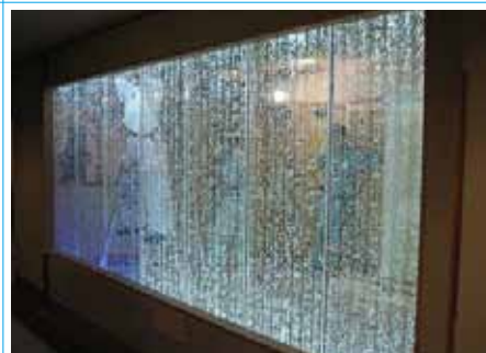
観音温泉ホテル ウォーターパネル 静岡県 ■ホテルの宴会場へとつながる通路に、ウォーターパネルを7枚連結し、水のパーテーションを設置。センサーにより、エアと照明を制御することで、空間を演出。
